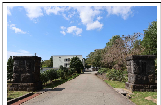
昭和53年3月校門竣工
