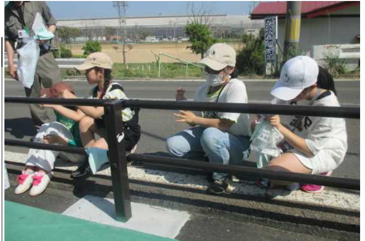
★県道男鹿半島線の防護柵への反射板取付…金川踏切付近(4～6年)
