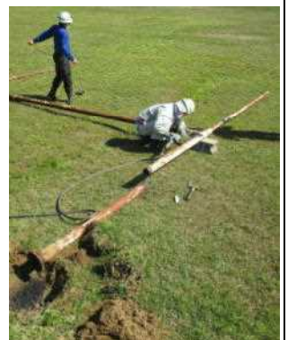
★ガスバーナーでの撤去作業の様子
